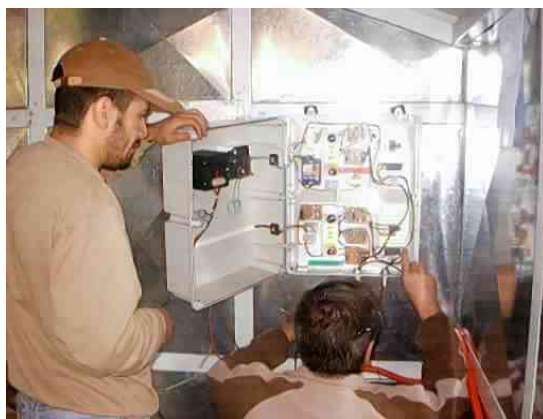
Fig. 7 Montaje del regulador en el aprovechamiento
