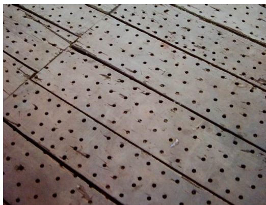
Piso de la zona de recepción.
