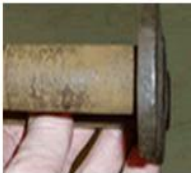
Corrosión de picadura
