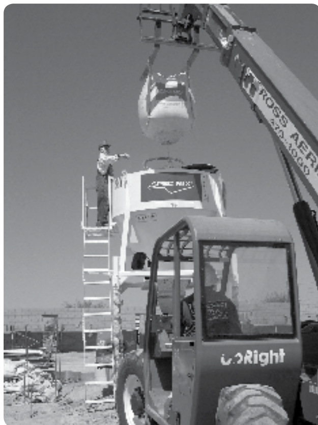
Solución: Carga de un sistema de silo
