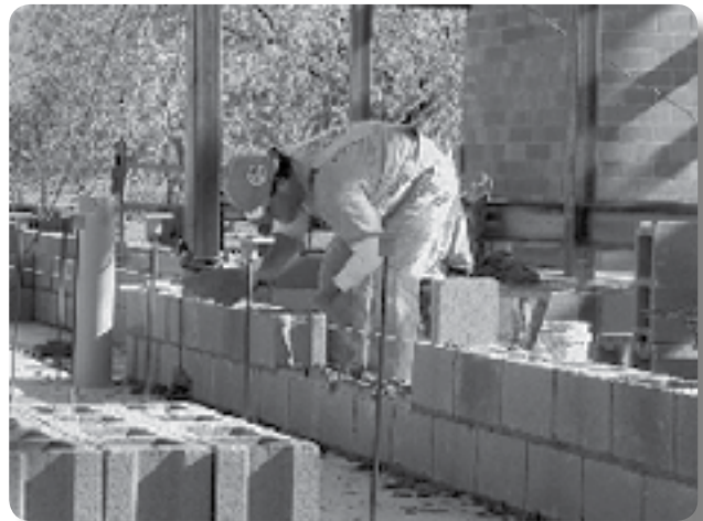
Problema: Instalación de bloques de concreto estándar
