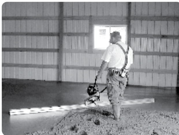
Solución: Uso de una niveladora motorizada
