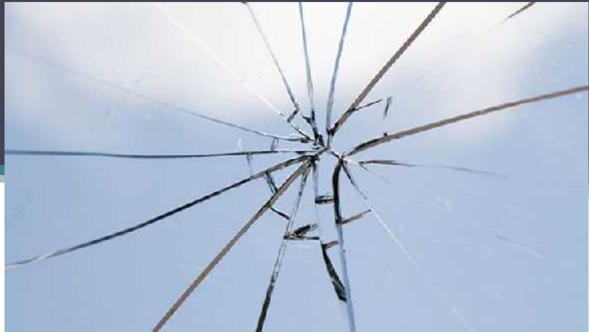
Rotura de un vidrio recocido.
