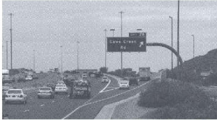
Figura 10-64. Área de nesga, salida de un solo carril
