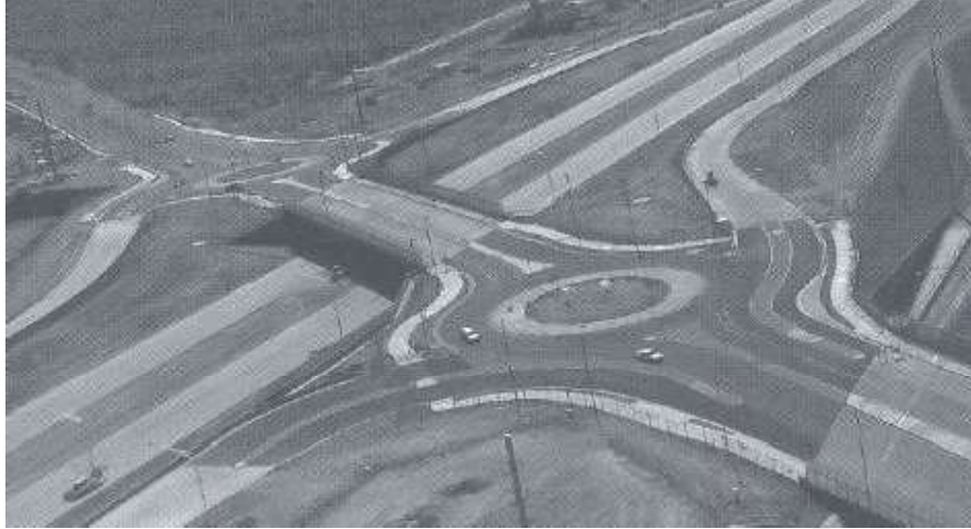
Figura 10-22. Distribuidor diamante con rotondas en los terminales de rama y camino transversal
