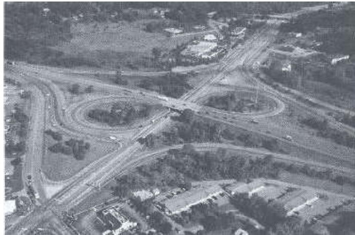
Figura 10-27. Distribuidor Trébol parcial Fuente: Michigan DOT
