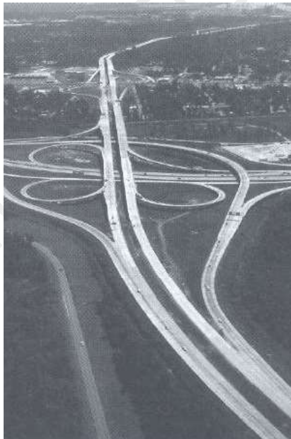
Figura 10-42. Distribuidor Trébol con conexión semidirecto
