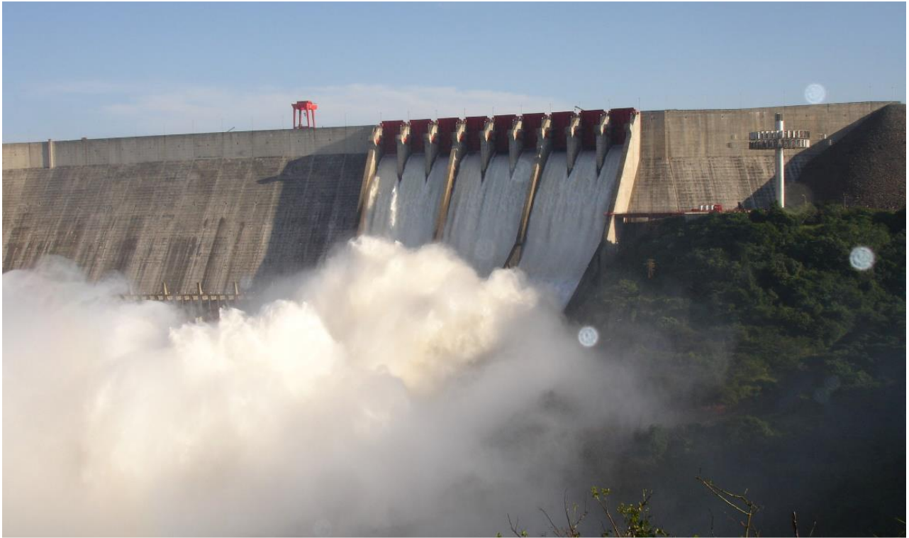
Aliviadero de la Presa Guri, Venezuela
