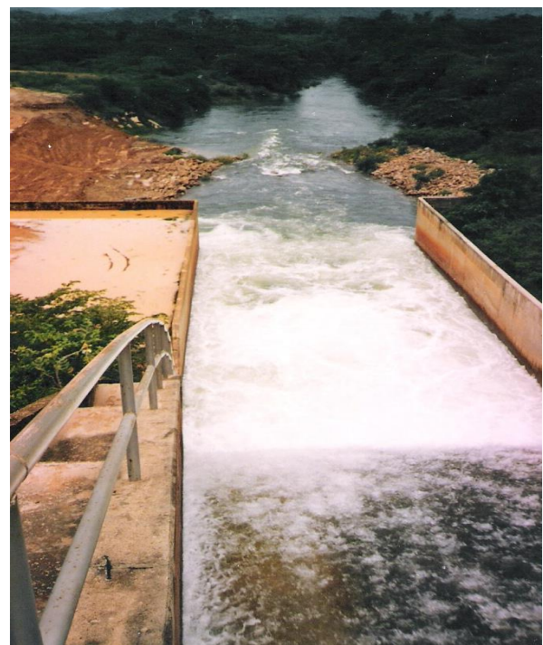
Resalto en el dissipador de energía del aliviadero de la Presa Socuy, Venezuela.
