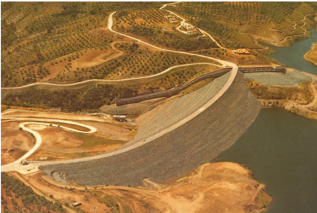
Aliviadero de entrada lateral. Presa del Yegüas (España). Gráfico: Ministerio de Transición Ecológica (España)
