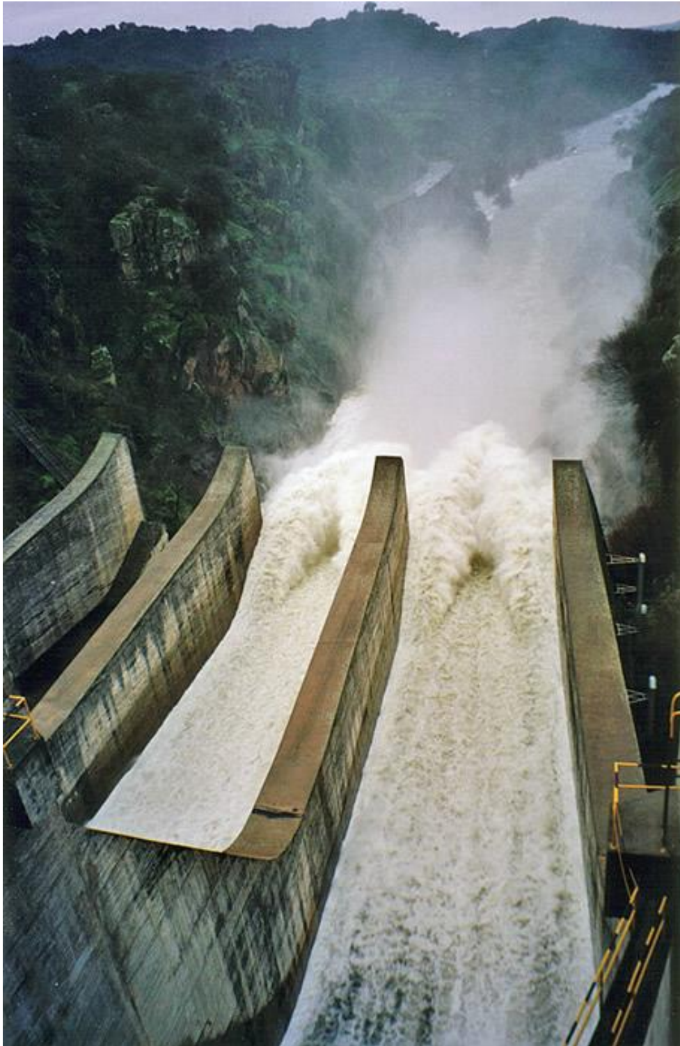
Aliviadero de 3 vanos. Presa de Valdeobispo. España. www.valdeobispo.net
