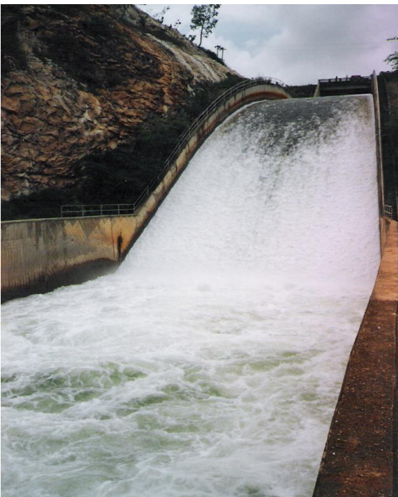
Resalto en el dissipador de energía del aliviadero de la Presa Socuy, Venezuela.
