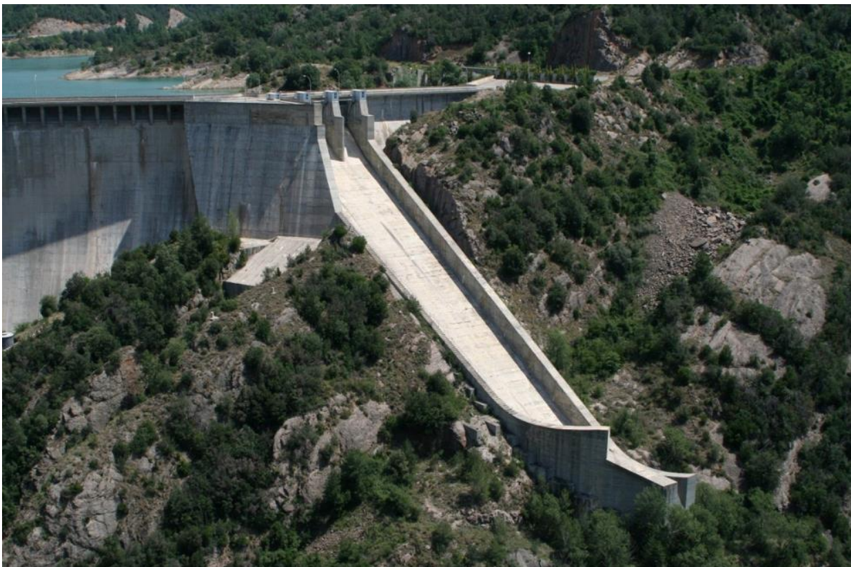
Aliviadero con trampolín. Presa de La Baells (España) Fotografía: Alfredo Granados
