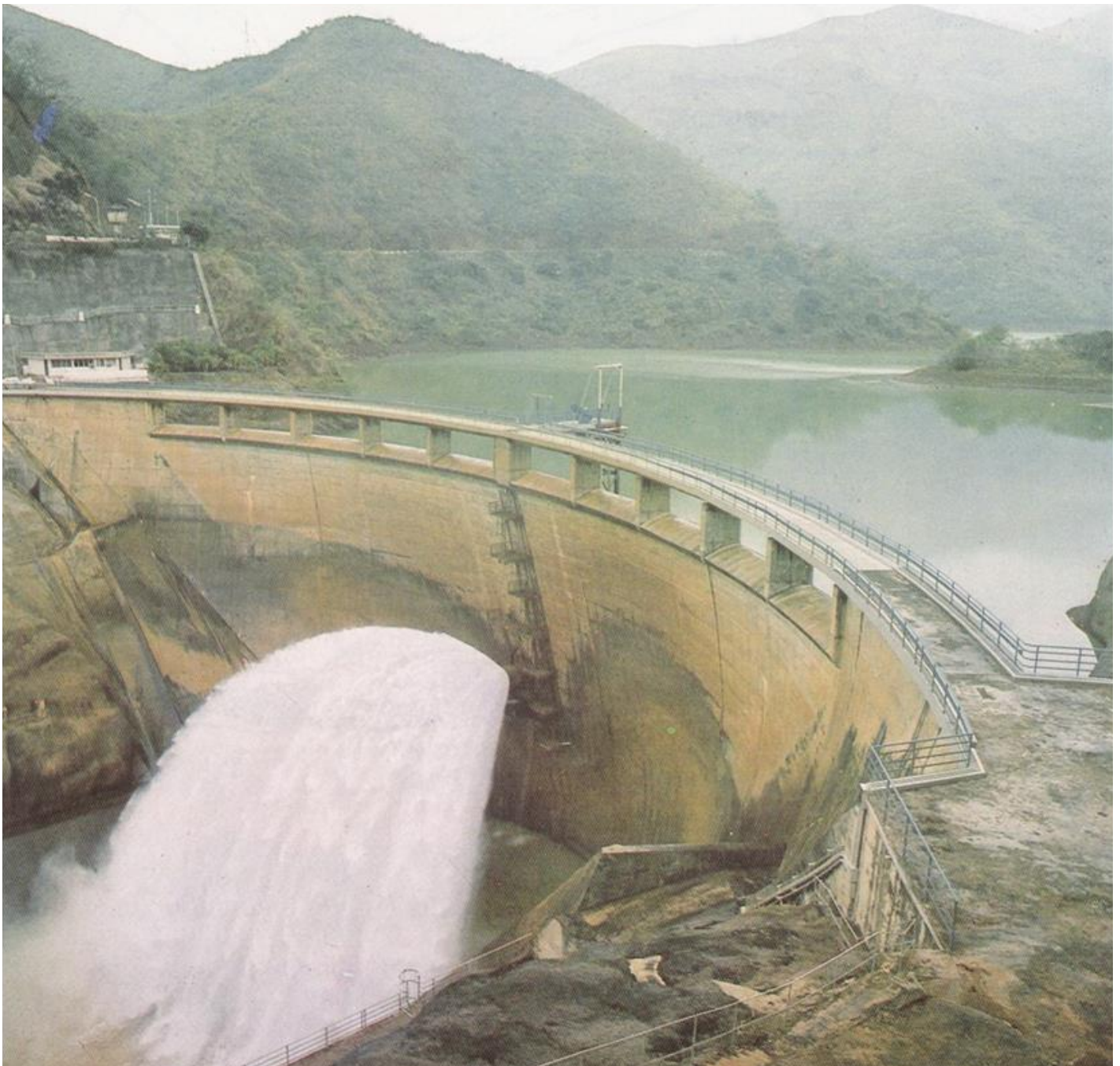
Válvula Howell - Bungler de la descarga de medio fondo, en operación. Presa Ocumarito, Venezuela.
