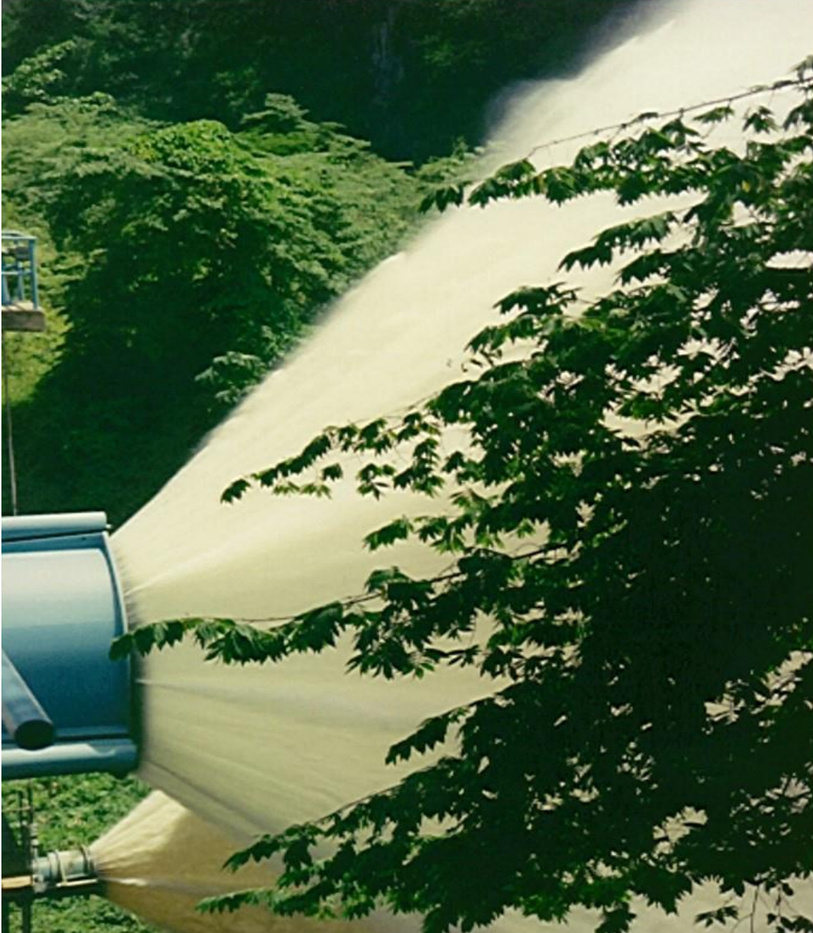
Embalse Turimiquire, Venezuela. Válvula superior: Howell - Bunger D=3\text{m} de la descarga de medio fondo.
