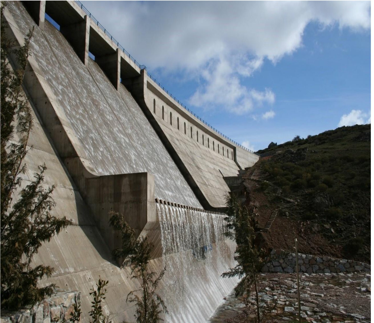
Aliviadero de superficie. Presa de Las Navas del Marqués (España) Fotografía: INPROES
