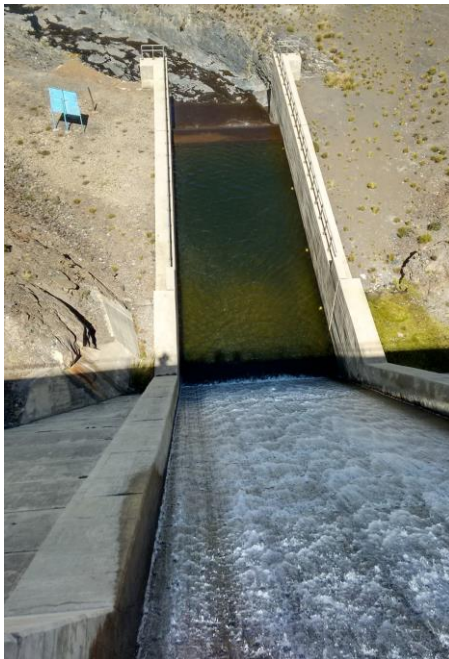
Izquierda: Resalto en el dissipador de energía del aliviadero de la Presa Ajuan Khota, Bolivia.
