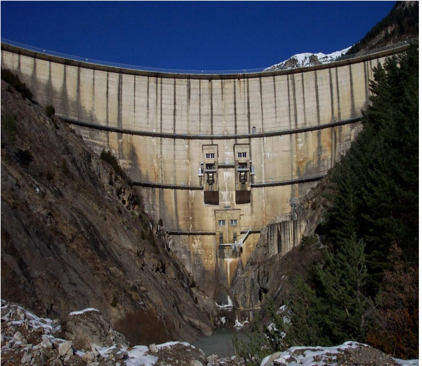
Aliviadero en carga. Presa de Lanuza (España). Fotografía: Confederación Hidrográfica del Ebro
