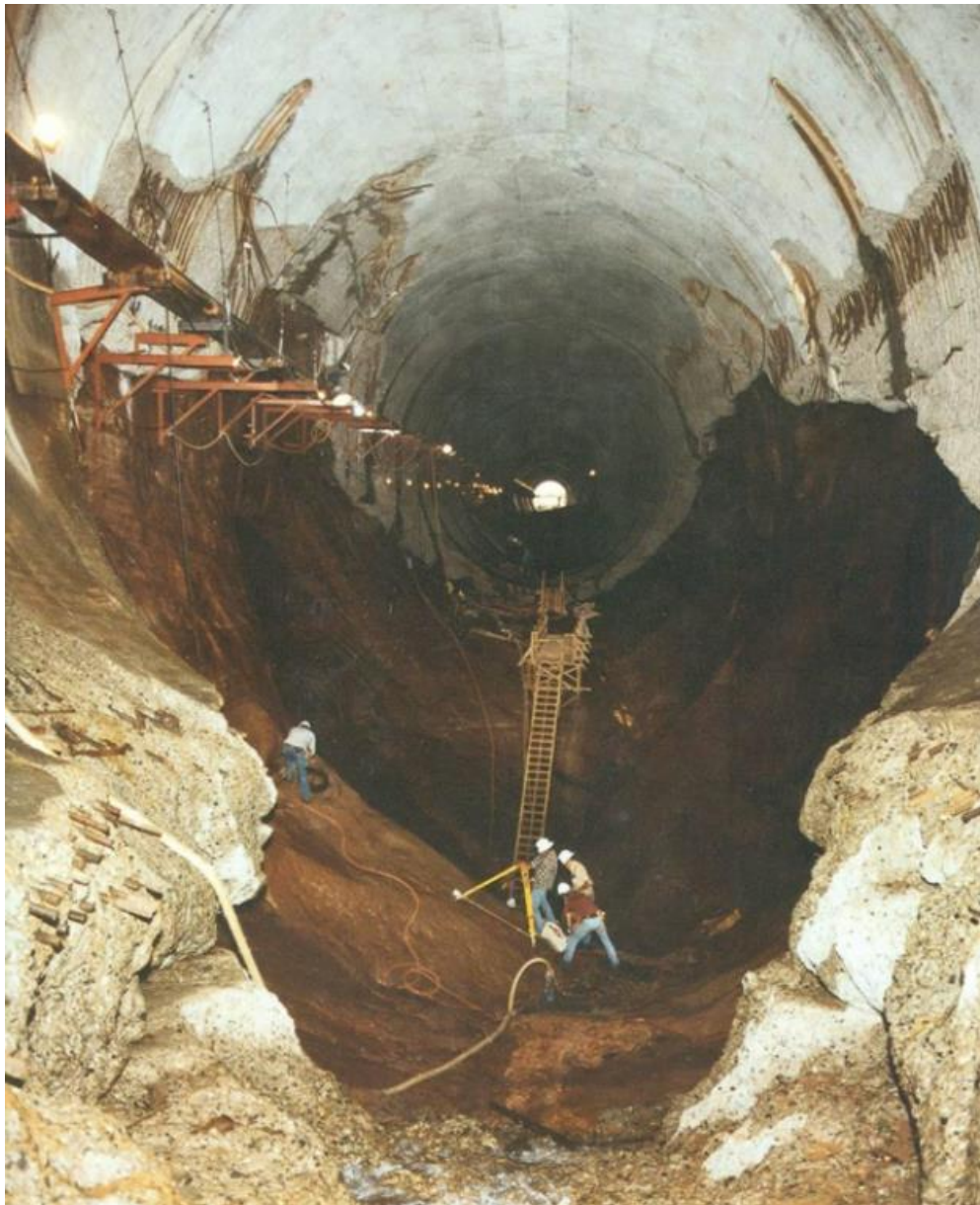
Daños por cavitación en el aliviadero de la presa de Glen Canyon (EEUU).
