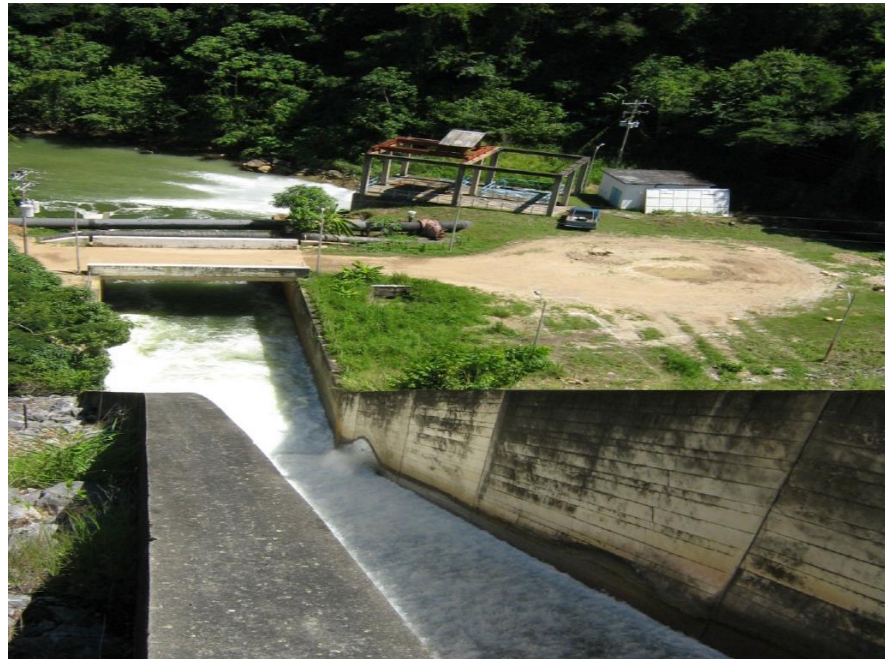
Izquierda: Resalto en el dissipador de energía del aliviadero de la Presa Ajuan Khota, Bolivia.
