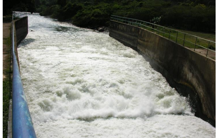
Rápida en la salida del túnel de toma y Resalto en el dissipador de energía de la toma de la Presa Agua Viva, Venezuela
