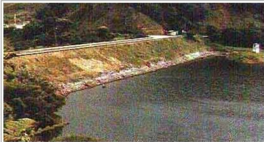
- Presa de tierra
