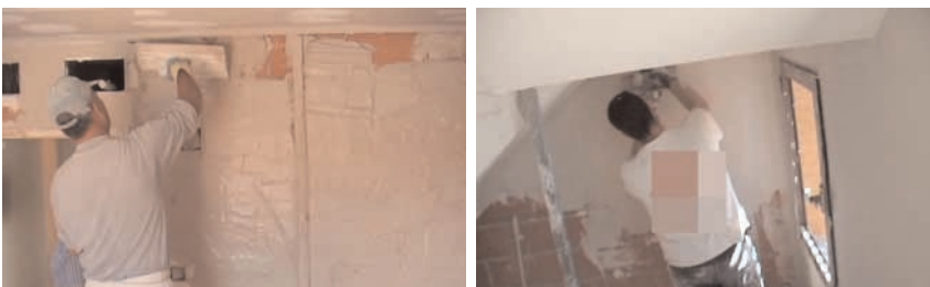
Figura 103 - Yesista: trabajo en paredes.
