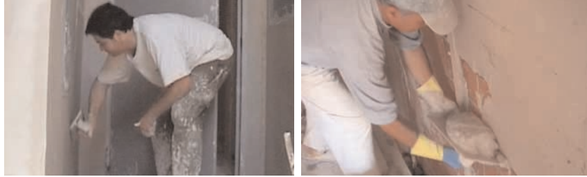
Figura 104 - Yesista: trabajo en paredes.
