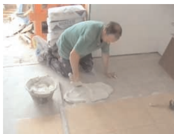
Figura 89 - Solador: trabajo de rodillas.
