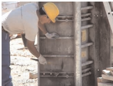
Figura 51 - Encofrador: fuerza impulsiva.
