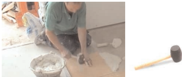
Figura 98 - Ajustar baldosas con maza de goma.
