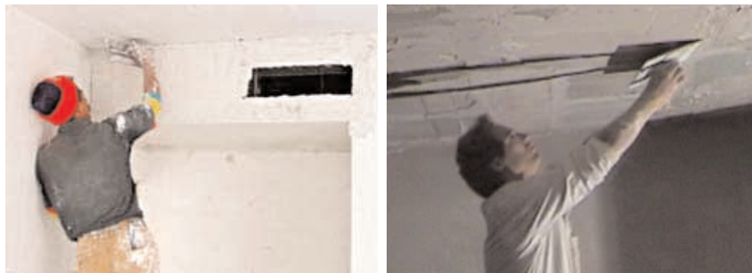
Figura 100 - Yesista: trabajo en techo.
