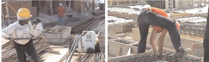
Figura 65 - Ferrallista: trabajo en superficies irregulares.
