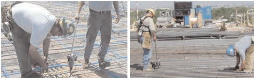
Figura 70 - Mango extendido en una herramienta eléctrica para el atado de ferralla.
