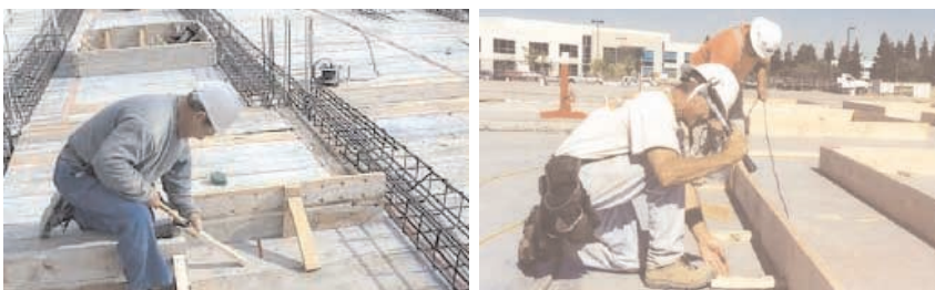
Figura 48 - Encofrador: posturas forzadas de piernas.
