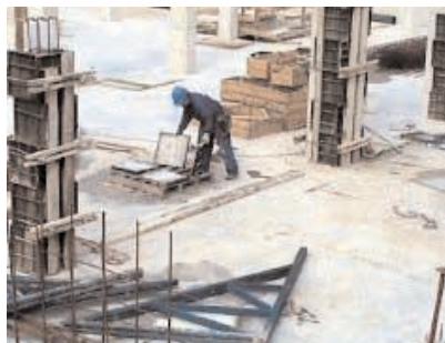
Figura 45 - Encofrador: recoger material a ras de suelo.
