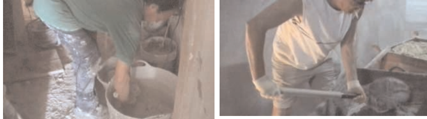
Figura 93 - Solador: realizar mezclas y palear.
