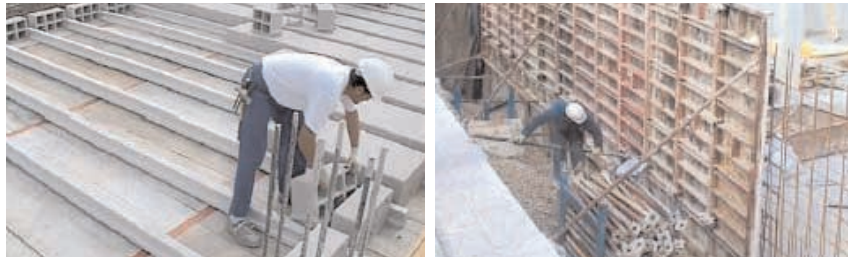
Figura 50 - Encofrador: manejo de cargas.
