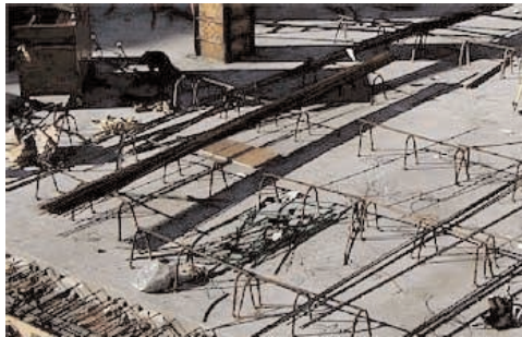
Figura 67 - Plataformas para colocar las barras.
