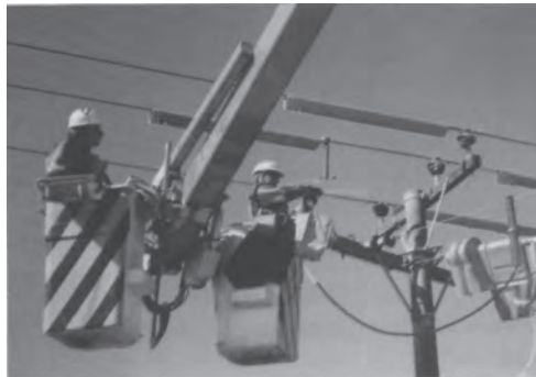
Figura 9.6. Trabajo en equipo (trabajo bajo tensión)
