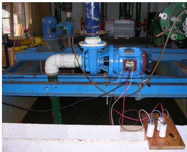
Figura 7: Bomba centrífuga como unidad generadora.
