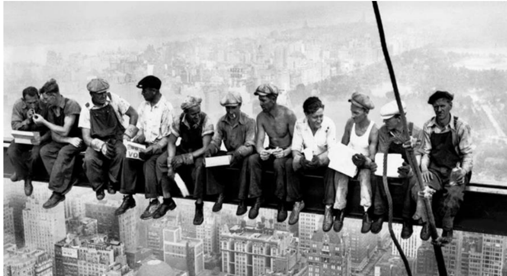
“Lunch Atop a Skyscraper” Rockefeller Center, GE Building. Construcción del piso 69° a 240 metros de altura. 1932
