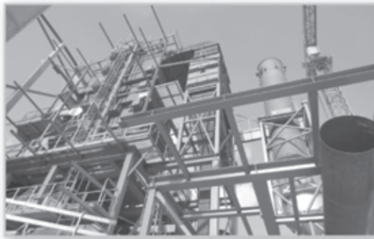
Deflexión de vigas
