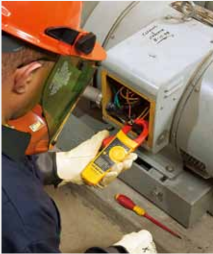
Utilice una pinza amperimétrica de la clasificación correcta para medir las cargas del motor.
