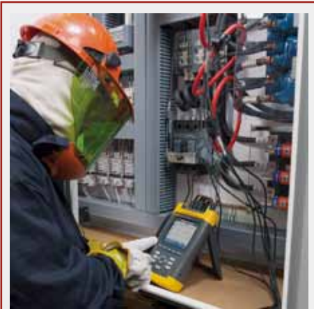
Los osciloscopios portátiles se pueden utilizar para pruebas eléctricas básicas así como para otras más avanzadas.
