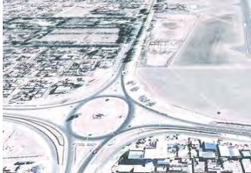
Vía de Penetración
